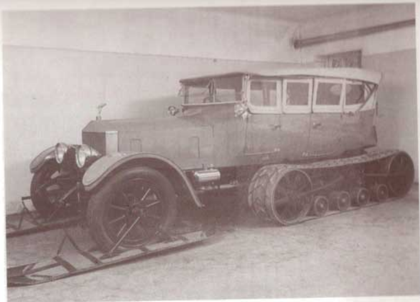
اتومبیل رولز رویسی که مخصوص استفاده لنین آن را به چوب‌های اسکی مجهز کرده بودند.
